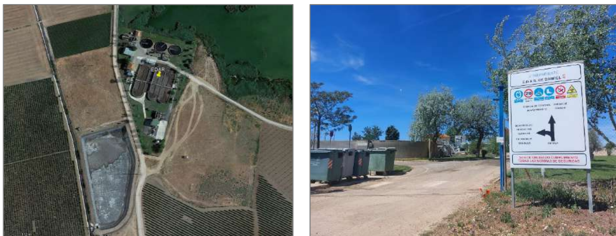
Figura 1. Localización y entrada a la EDAR de Daimiel
