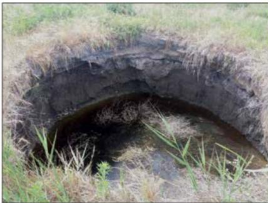
Colapso por combustión de turba
