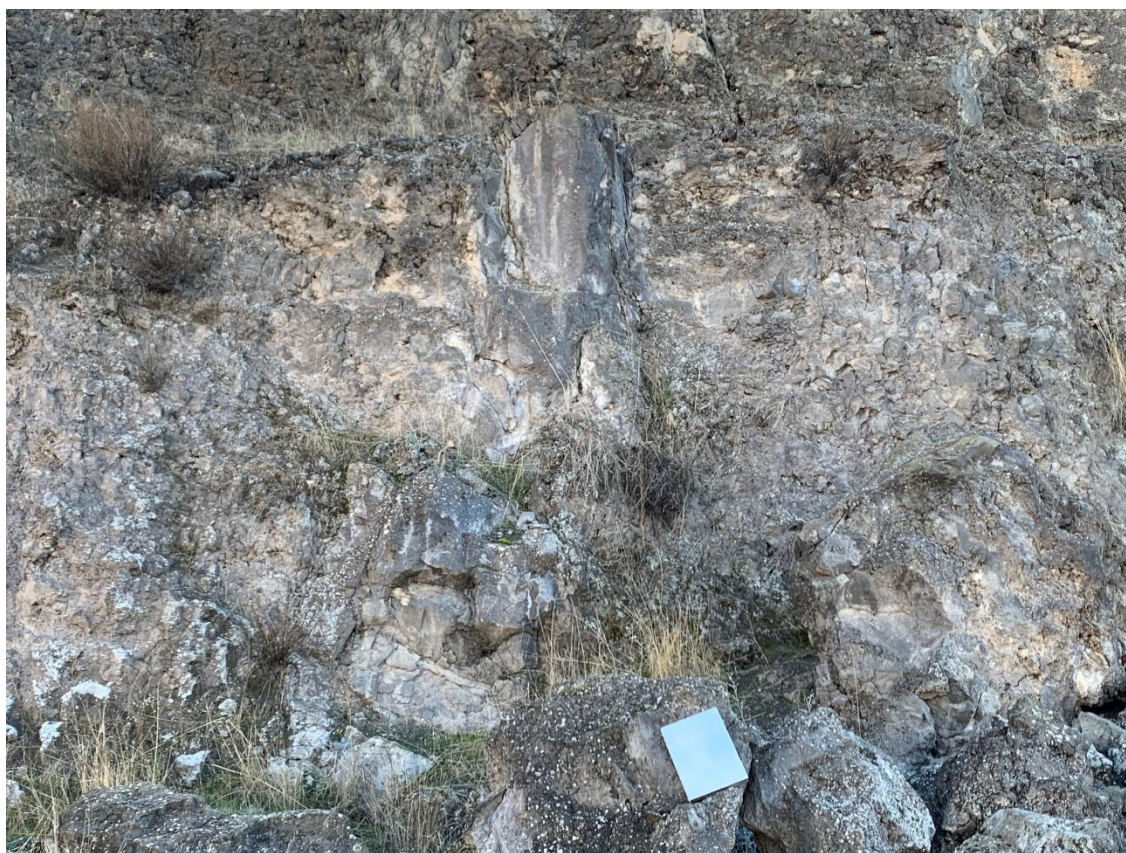
Figura 5.10.- Pto 13: Dique subvertical.
