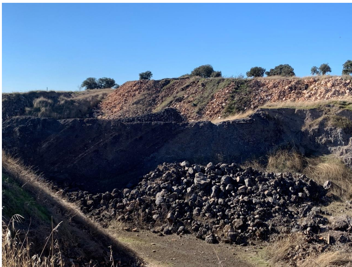
Figura 4.10.- Aspecto general de la cantera localizada en el Cono Volcánico Norte.
