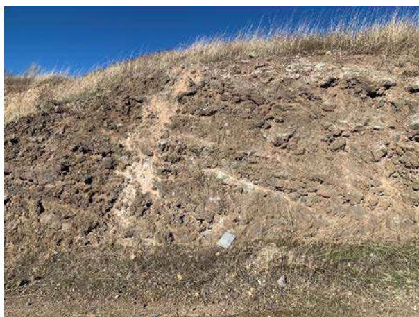
Figura 16. Punto de observación 1. Detalle de la estructura interna de la facies estratificada. Fuente: CRS Ingeniería.
