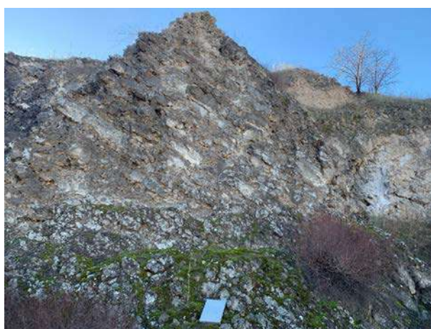
Figura 17. Punto de observación 22. Buzamientos de niveles hacia el interior del cono. Fuente: CRS Ingeniería.
